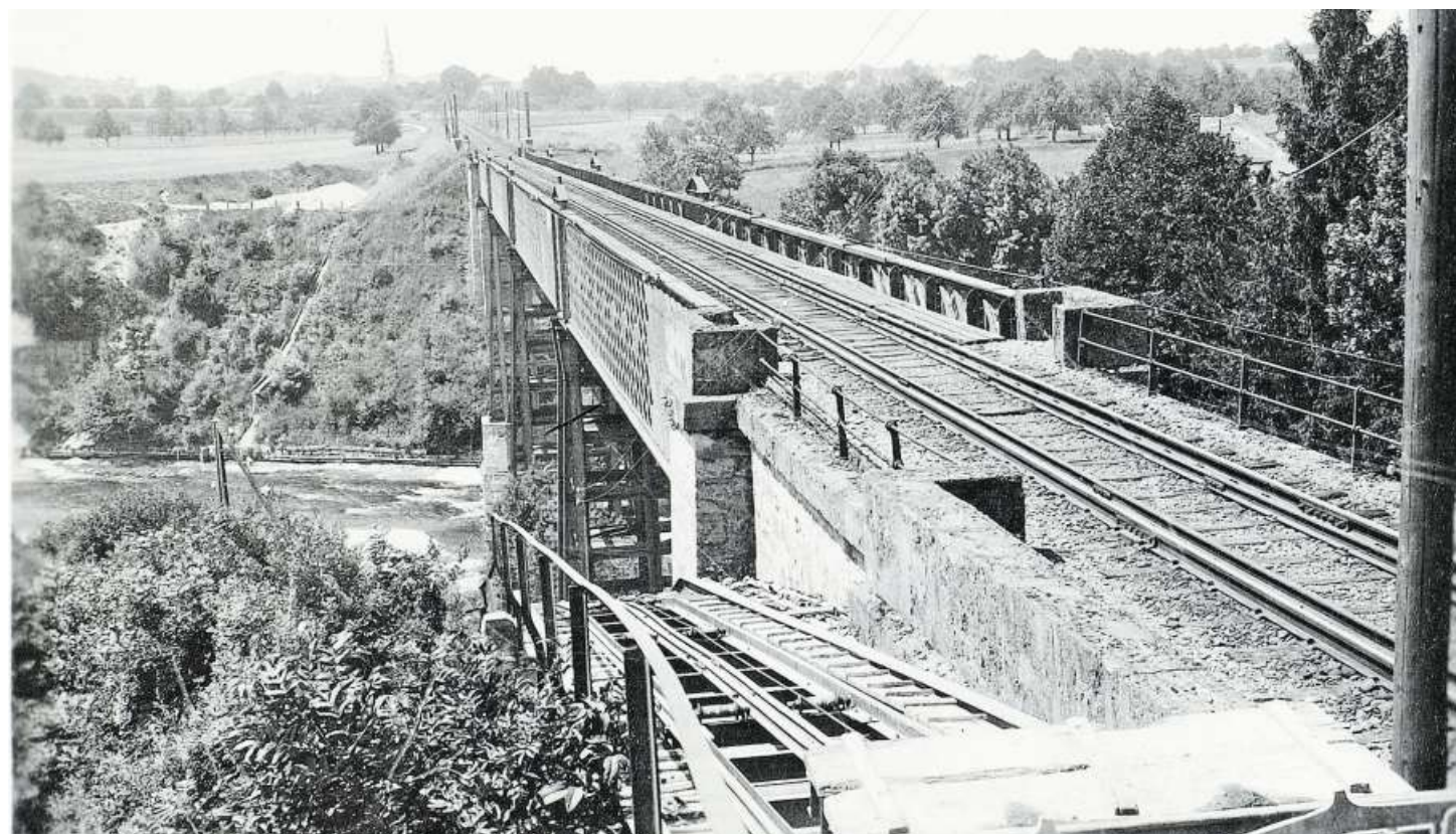
Das Archivbild der Thurbrücke Schwarzenbach zeigt den Schrägaufzug zur Kiesförderung in den 20er-Jahren.
